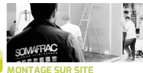
MONTAGE SUR SITE
